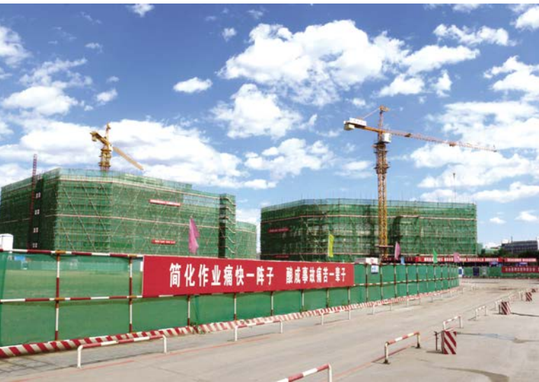
保华国际学校项目（2015 年度“美丽工地”）
