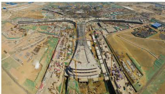
楼体完成 焊接钢架 2017.04.12
