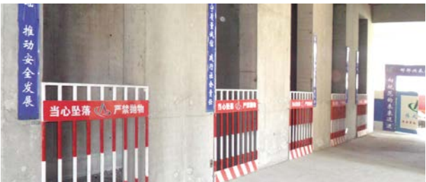
现场电梯井采用定型防护
