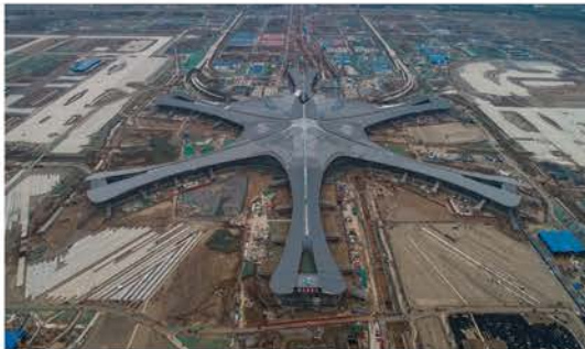
保温层完工 防水层施工 2018.04.23
