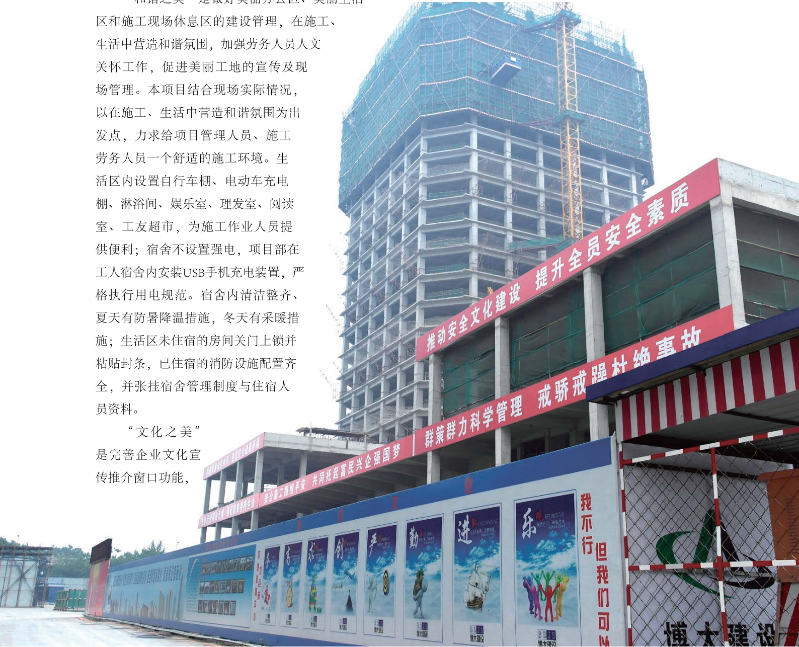
亦城财富中心项目（2013年度“美丽工地”）
