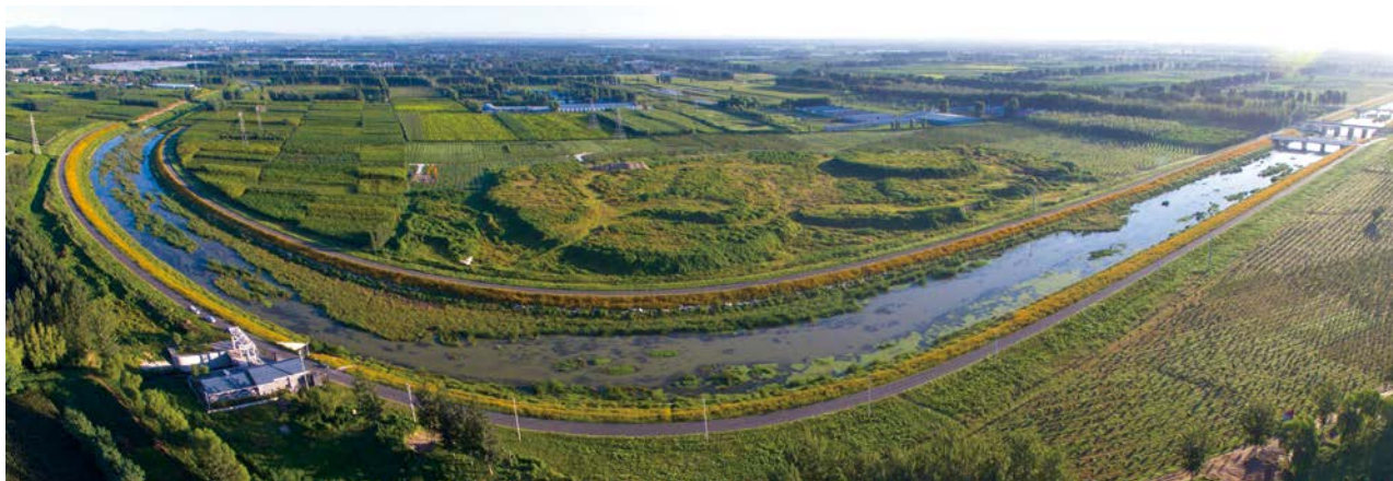
改线后的永兴河。潘清泉/摄
